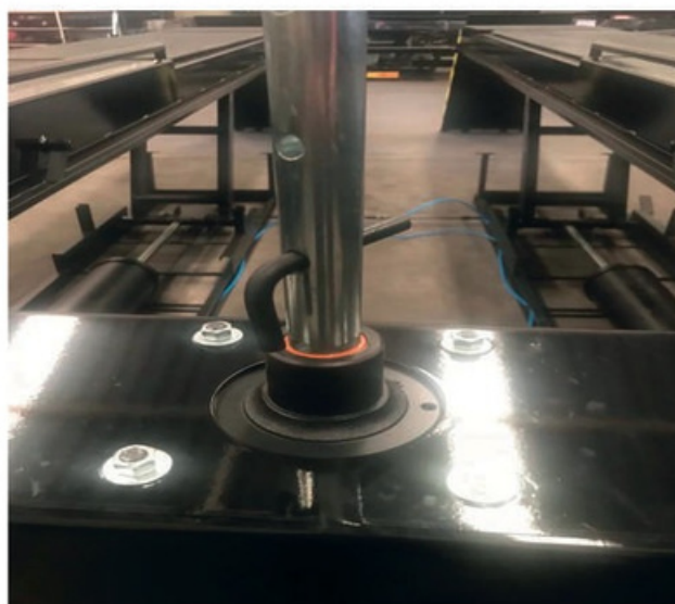
(FOTO 21: HASTE COM PINO APOIADO NA TAMPA)
