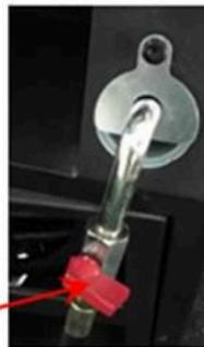
Válvula manual para descarga de óleo
